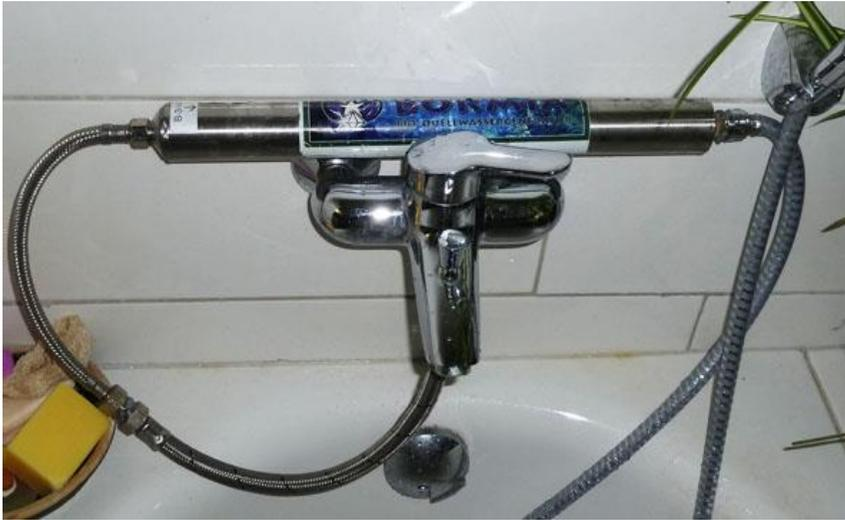
Hier wurde die Bormia-Quelle 20 Ltr. (als Einzelgerät) ohne weitere Befestigung auf die Armatur gelegt. Der Duschschlauch wird einfach am Ausgang der Bormia-Quelle montiert. Hier sollten bei Bedarf die Wandhalterungen [B-427] verwendet werden. Diese Anschlussweise kann beliebiger Temperatur ausgesetzt (max. 80°) werden, da es sich um 100% Edelstahl handelt.
